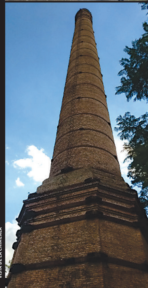
VISTA DE LA CHIMENEA
