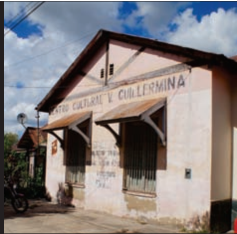
DETALLE DE LA FACHADA
