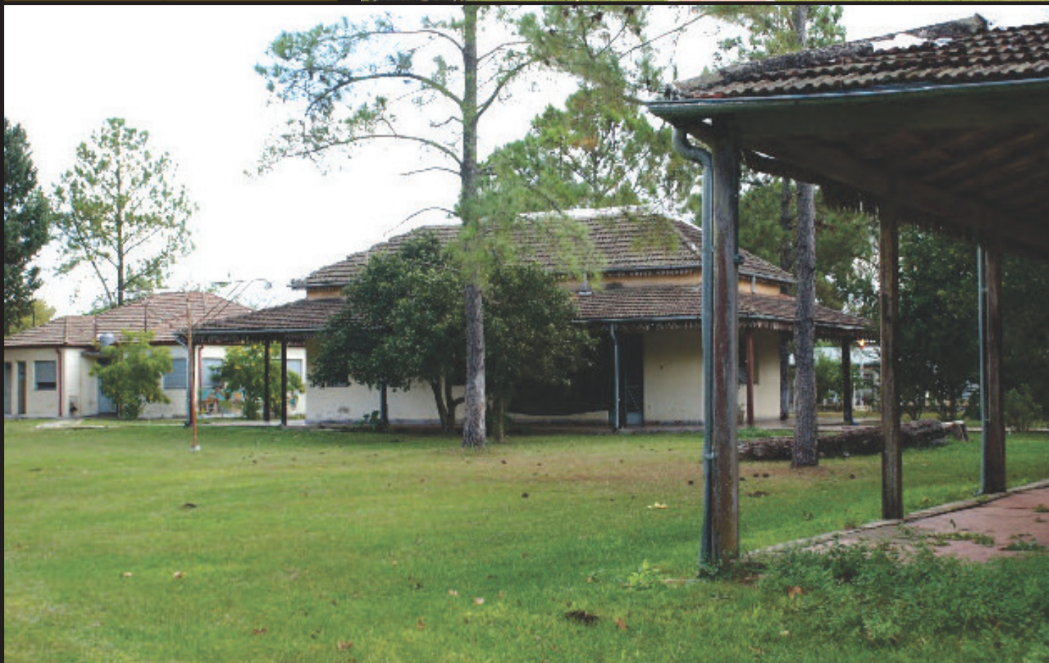
VISTA DE UN GRUPO DE PABELLONES
