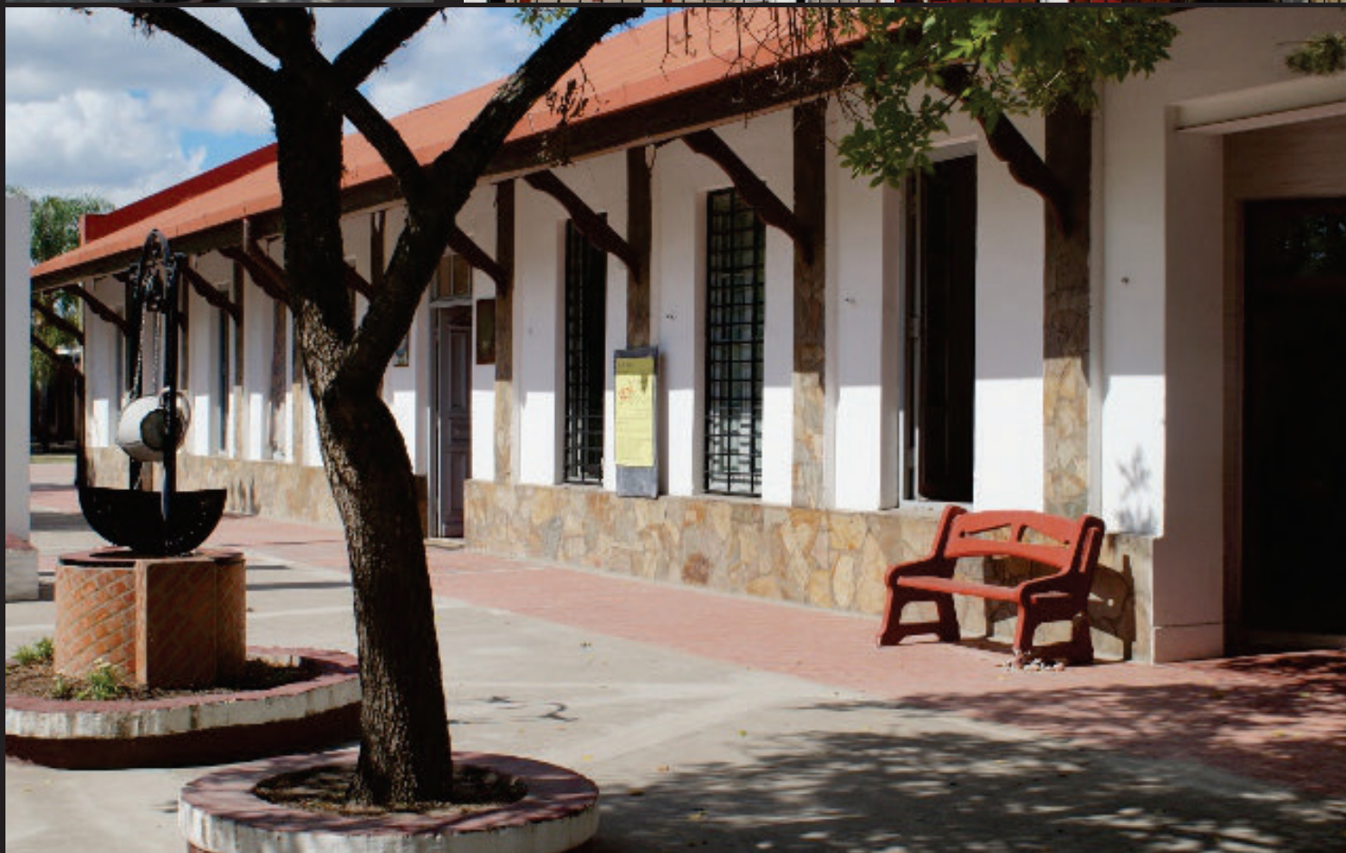
FACHADA PRINCIPAL Y ALJIBE
