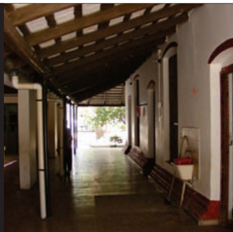
VISTA DE LAS GALERÍAS LATERALES
