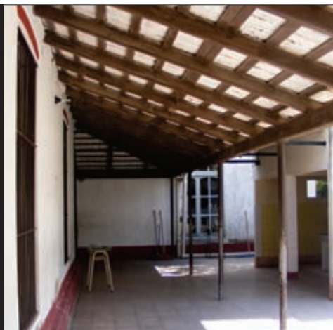
VISTA DE LAS GALERÍAS LATERALES
