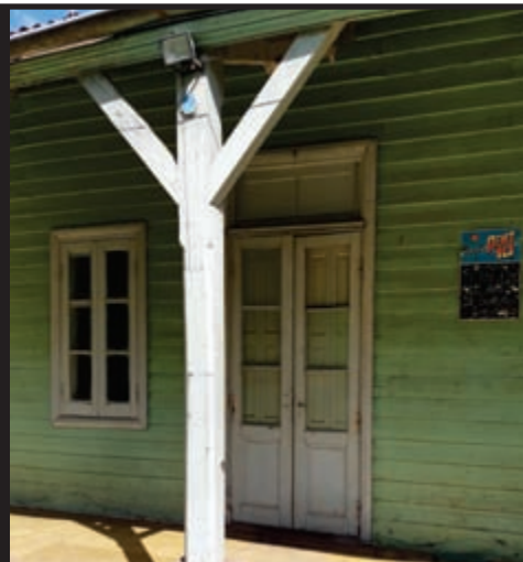
DETALLE DE MÉNSULAS «V» EN LA GALERÍA
