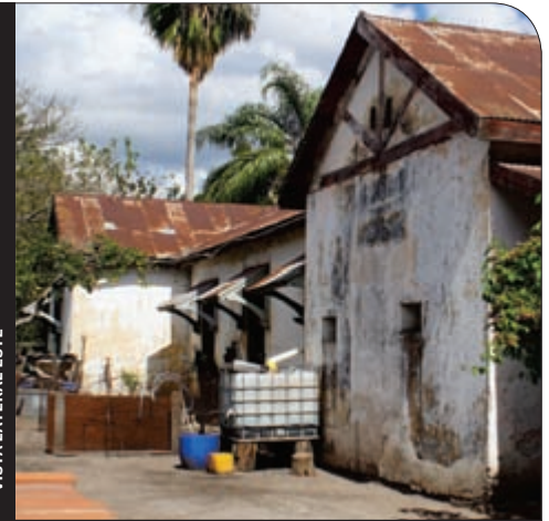
VISTA LATERAL ESTE
