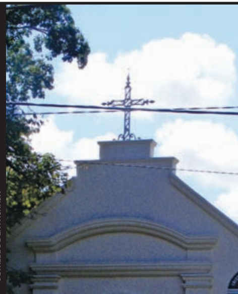
DETALLE DE LA FACHADA
