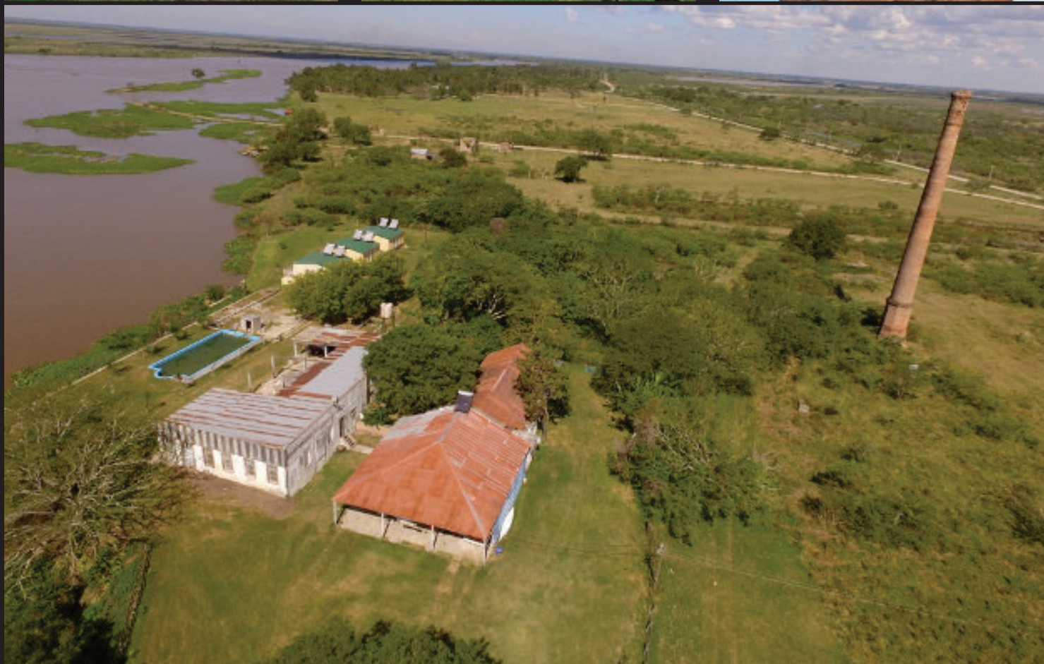
VISTA AÉREA DEL CONJUNTO
