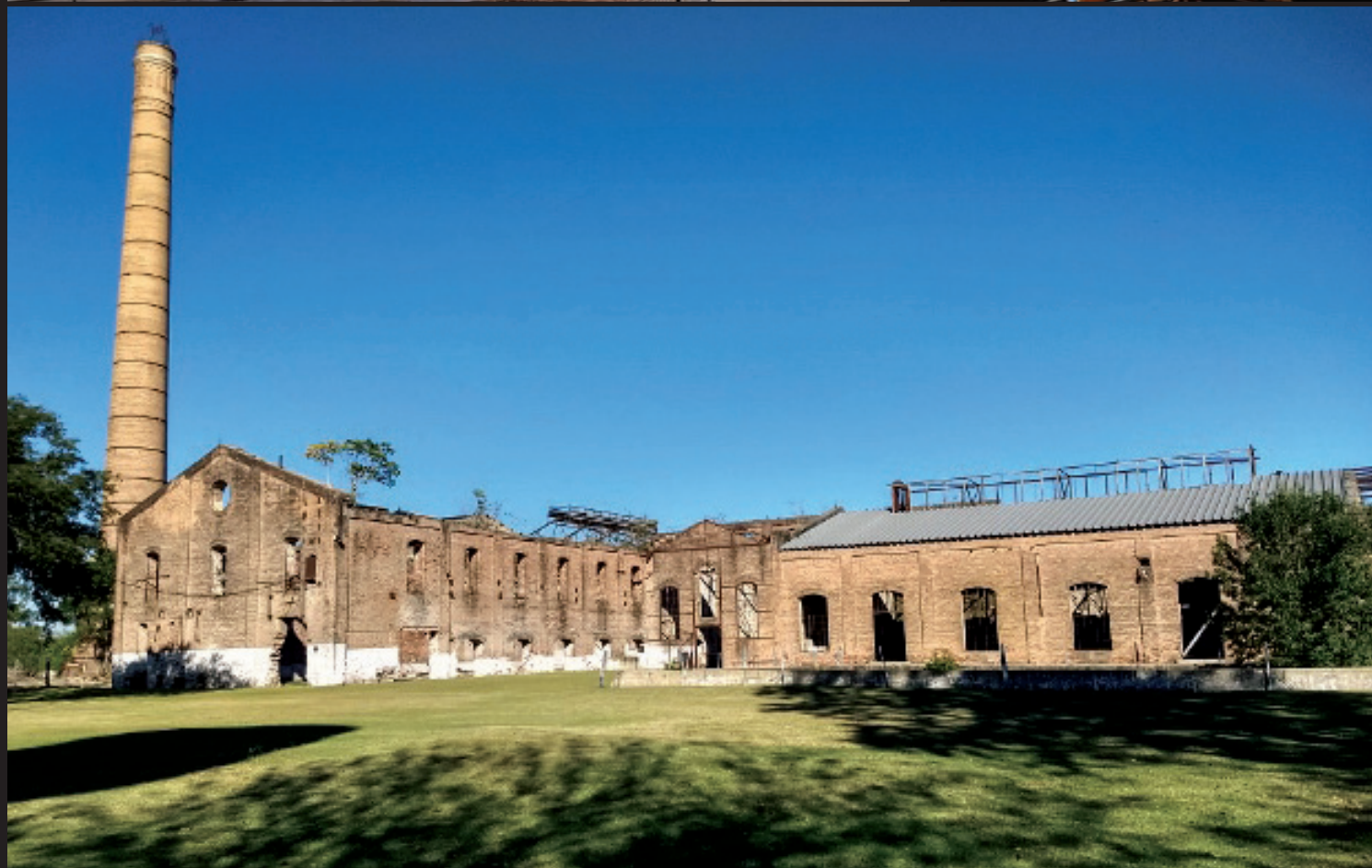
PANORÁMICA DEL CONJUNTO
