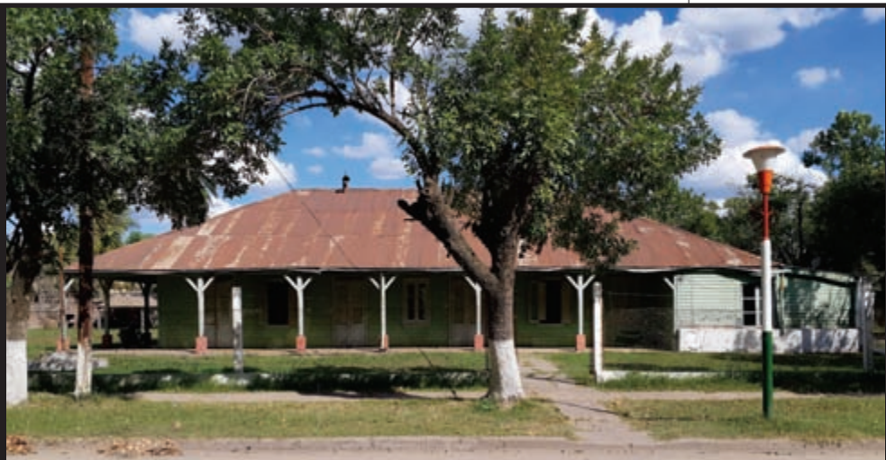
DETALLE DE MÉNSULAS «V» EN LA GALERÍA
